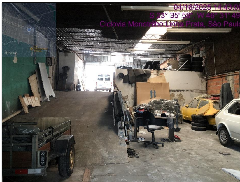
FOTO 13: Vista interna do galpão do imóvel avaliando.
