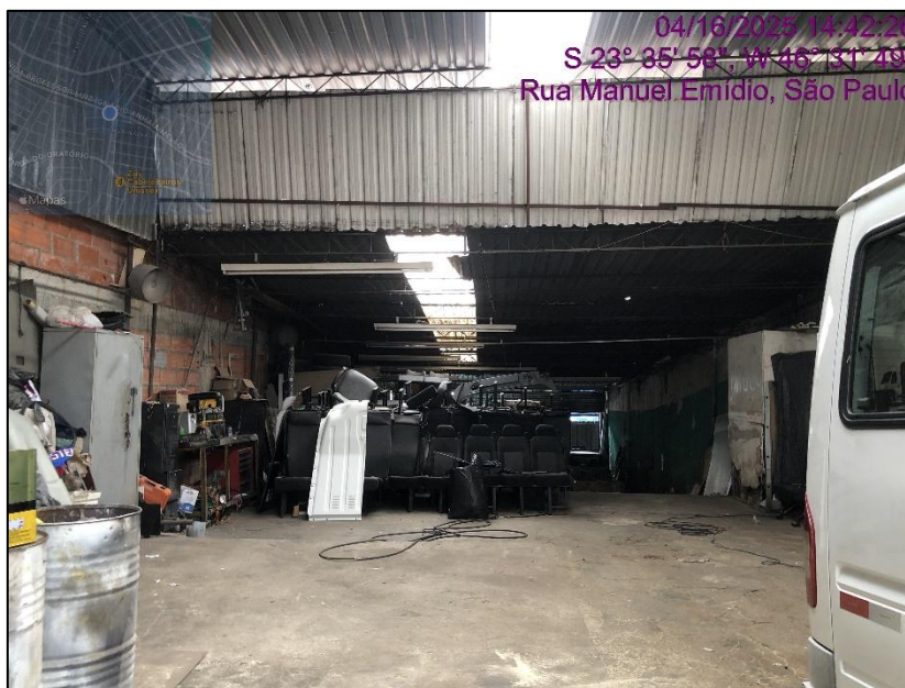
FOTO 10: Vista interna do galpão do imóvel avaliando.
