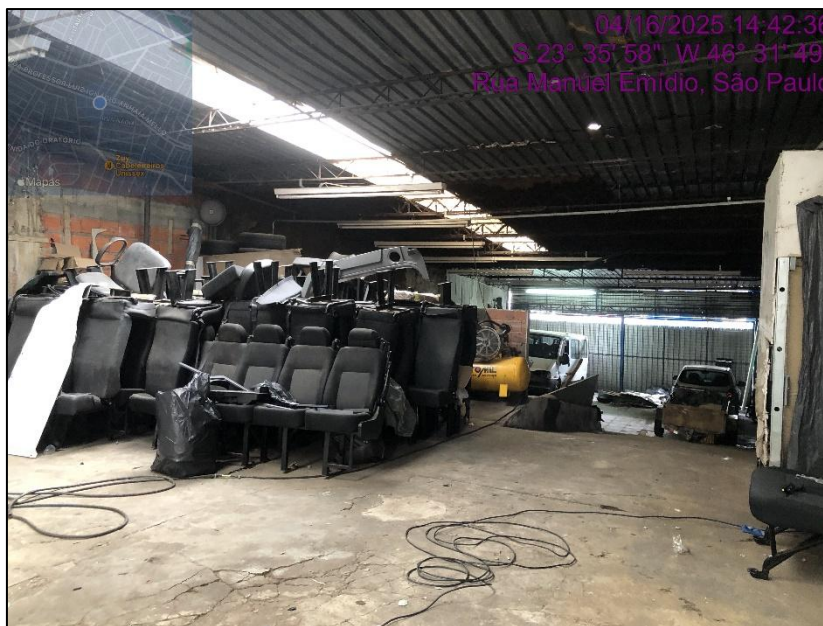
FOTO 11: Vista interna do galpão do imóvel avaliando.
