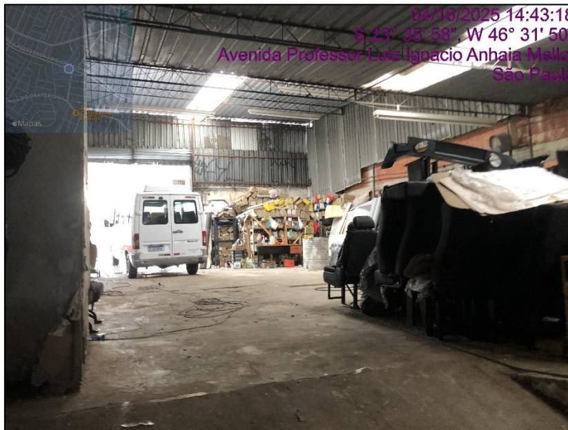
FOTO 14: Vista interna do galpão do imóvel avaliando.
