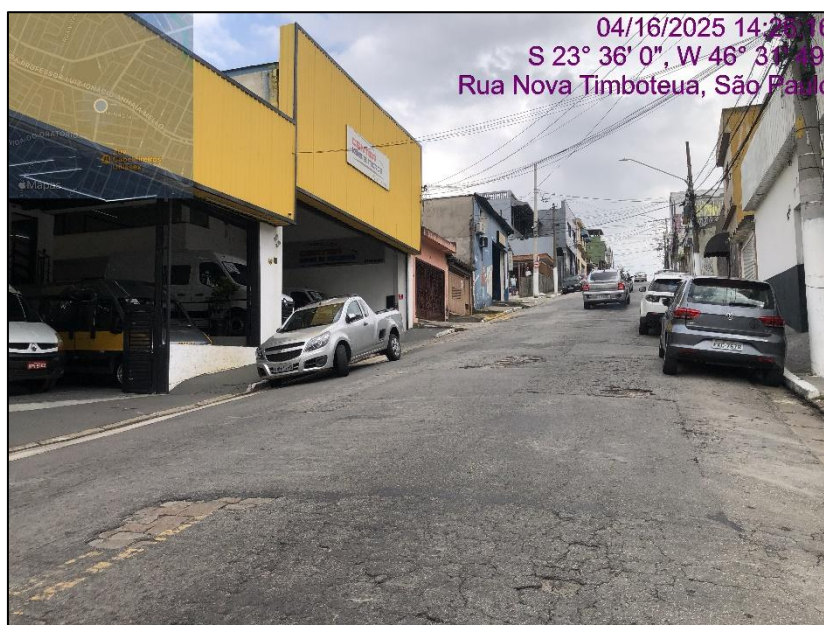
Foto 02: Outra vista do acesso pela Rua Nova Timboteua, onde se encontra o imóvel avaliando.
