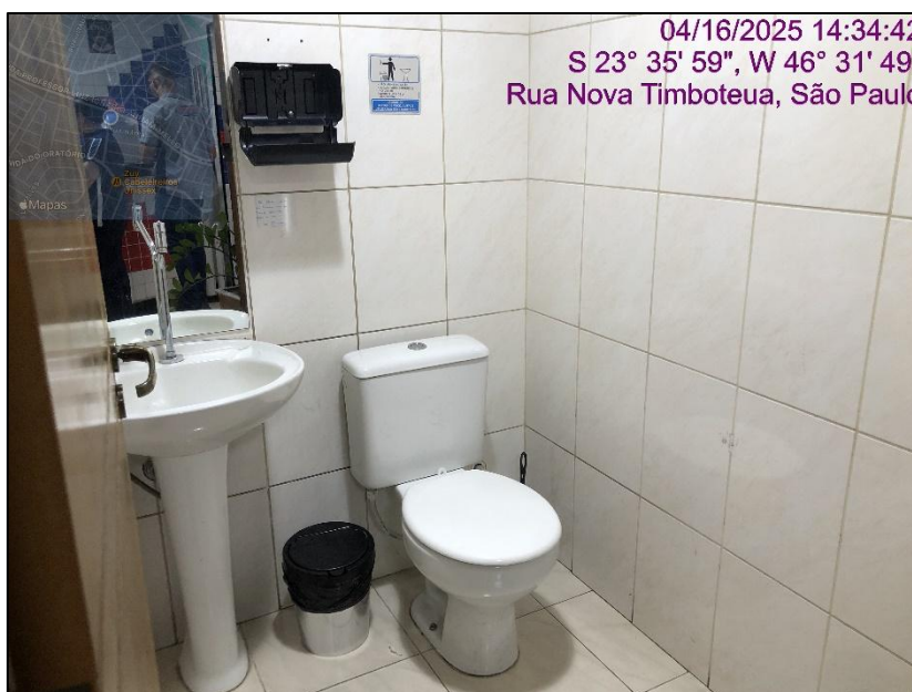
FOTO 18: Outra vista do banheiro da unidade avalianda.
