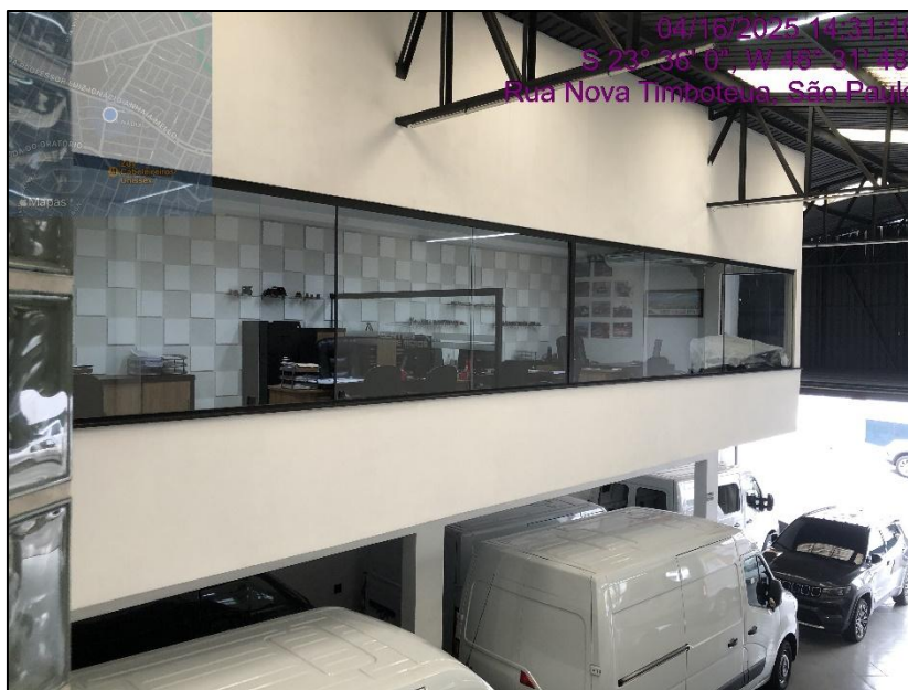
FOTO 22: Vista do mezanino da unidade avalianda.
