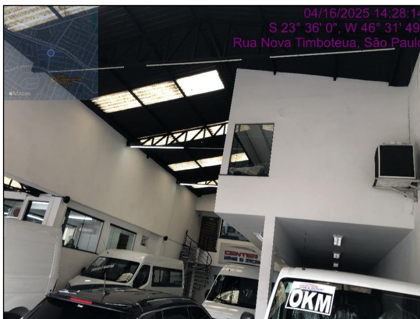
FOTO 09: Outra vista do galpão loja do imóvel avaliando.
