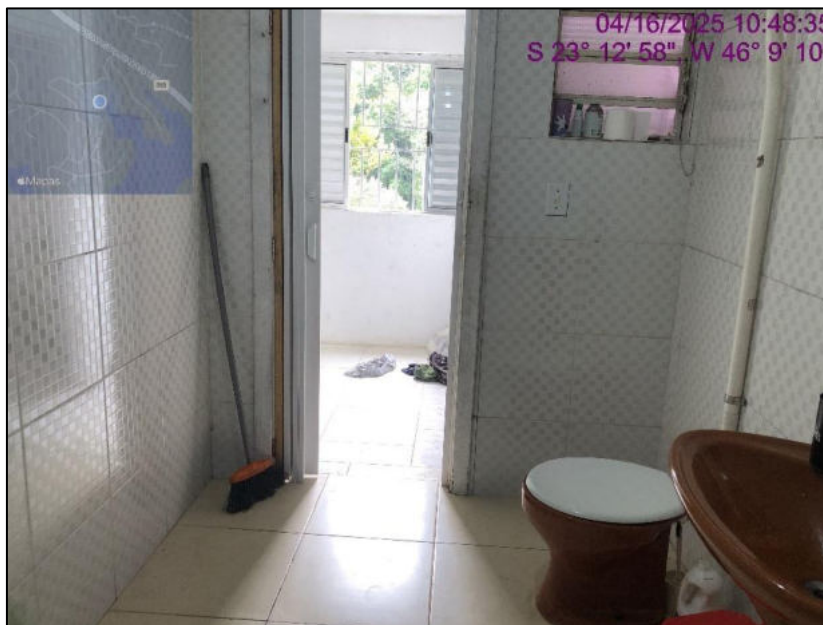
FOTO 65: Outra vista do banheiro social da casa do caseiro da unidade avalianda.
