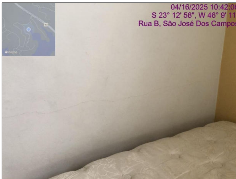
FOTO 28: Detalhe de trinca parede do dormitório 1 da casa principal da unidade avalianda.
