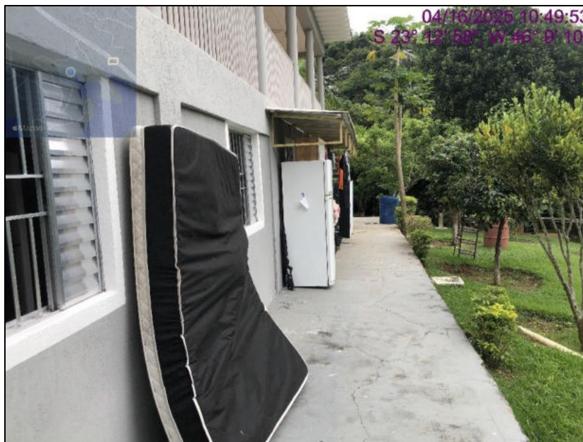
FOTO 51: Outra vista do corredor da casa do caseiro da unidade avalianda.
