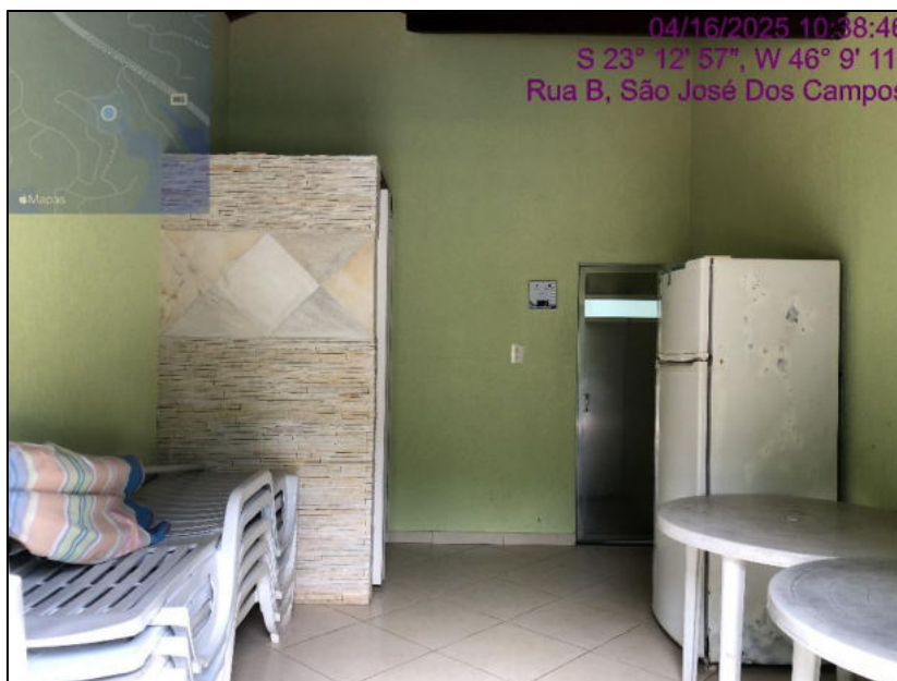
FOTO 17: Vista do vestiário da unidade avalianda.
