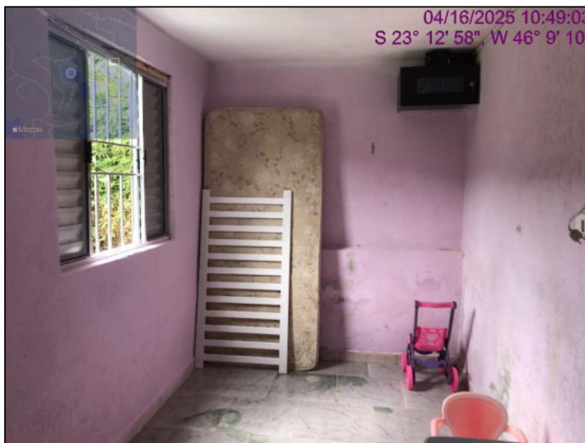
FOTO 69: Vista do dormitório 3 da casa do caseiro da unidade avalianda.
