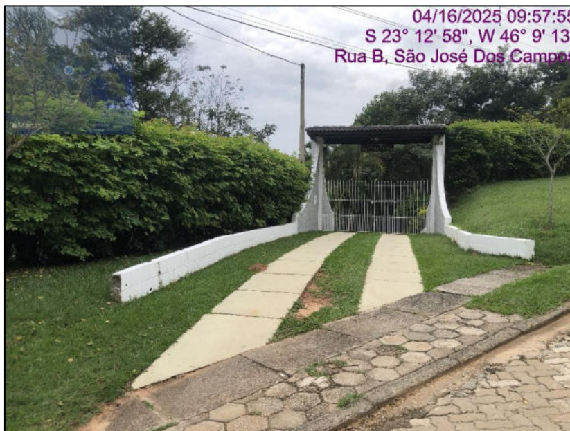
FOTO 04 Vista da entrada de acesso ao imóvel avaliando.
