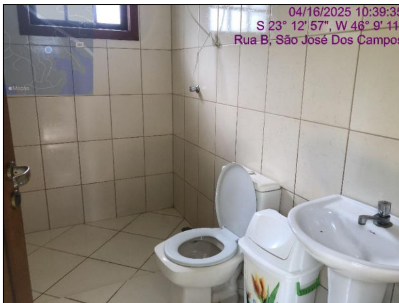
FOTO 21 Vista banheiro piscina 1 da unidade avalianda.
